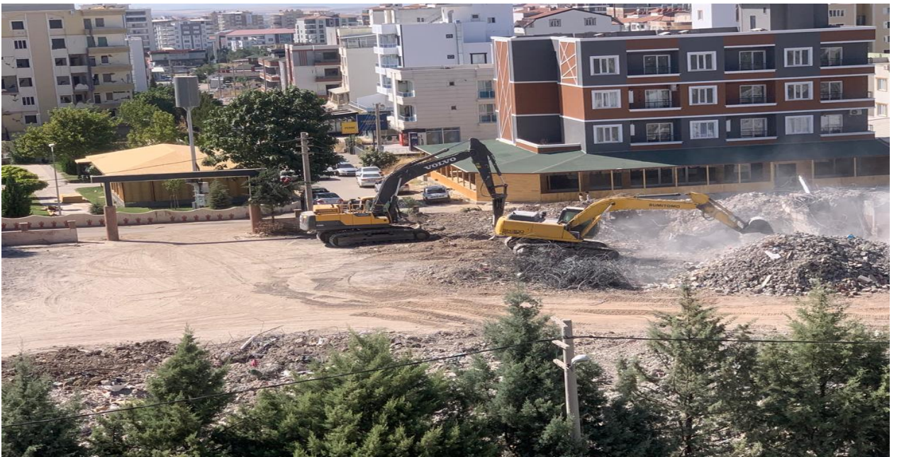
Foto 6: Adıyaman'da, demiri enkaz alanında ayrıştırılan bir enkaz kaldırma faaliyeti-11.08.2023
