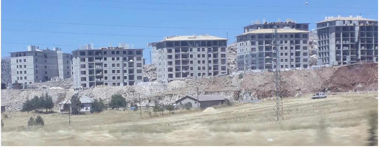
Foto 4: Göksun'da yapılan yeni deprem konutları-10.08.2023
