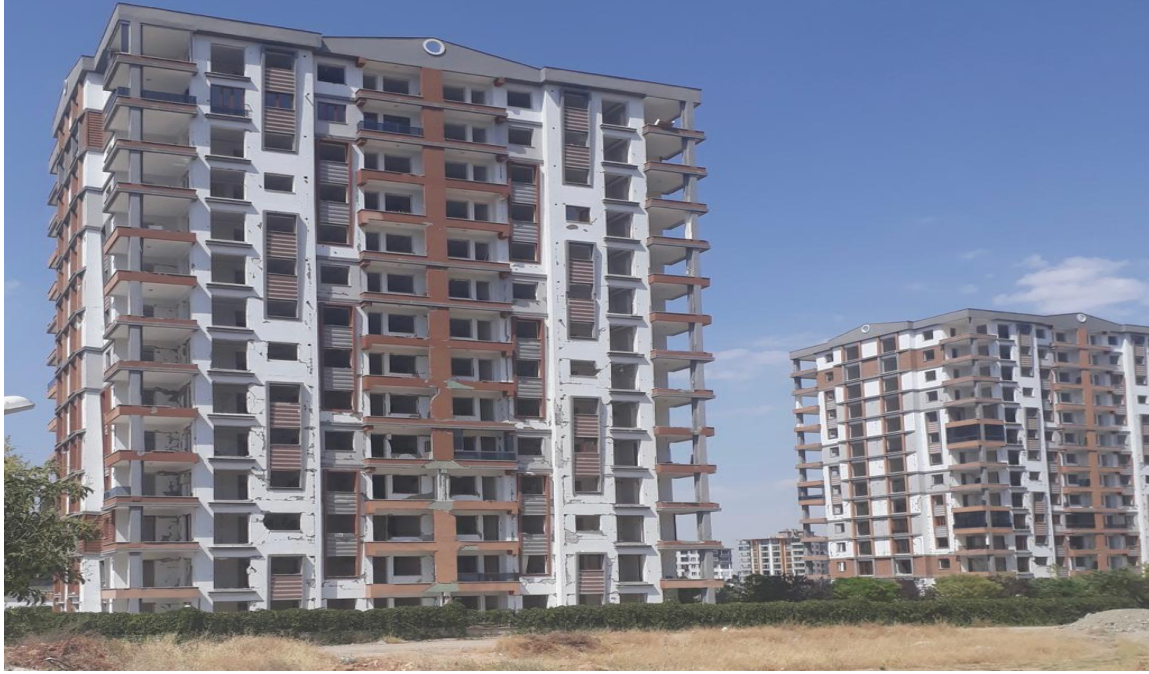
Foto 2: Malatya'da yıkım bekleyen binalar-09.08.2023
